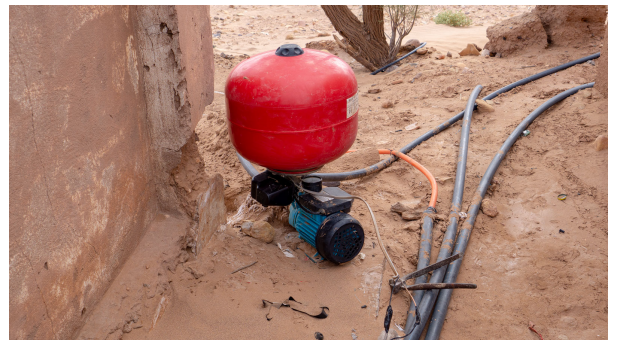
die jetzige anfällige Wasserpumpe
