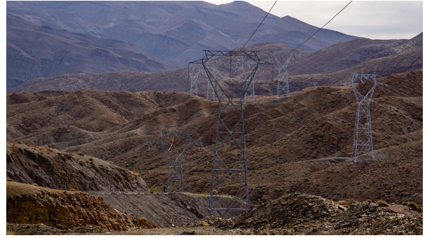
immer Stromleitungen im Weg
