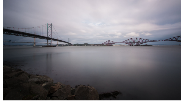
rechts Eisenbahnbrücke, mitte Strassenbrücke und ganz links die neue Strassenbrücke in Bau
