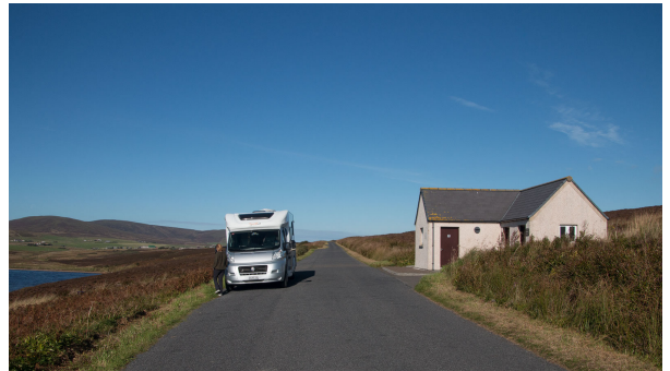
Entsorgung Waulkmill Bay
