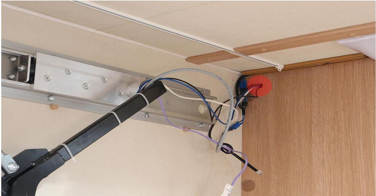
Nun stecken wir das schwarze Steuerkabel des Batteriecomputers durch das Loch und stecken viel Kabel nach. Danach „fische“ ich mit einem Stück gebogenem Draht das Steuerkabel wieder auf der Seite hervor.
