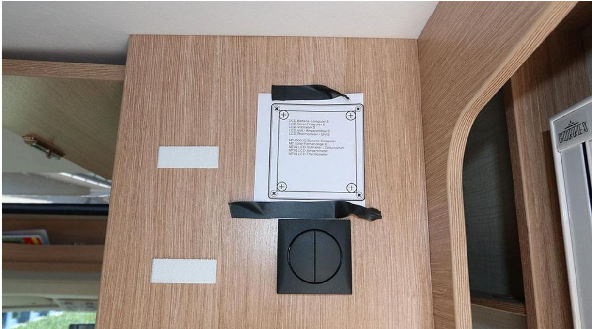
Löcher bohren und mit der Stichsäge die Löcher verbinden und schon sind wir fast fertig.
