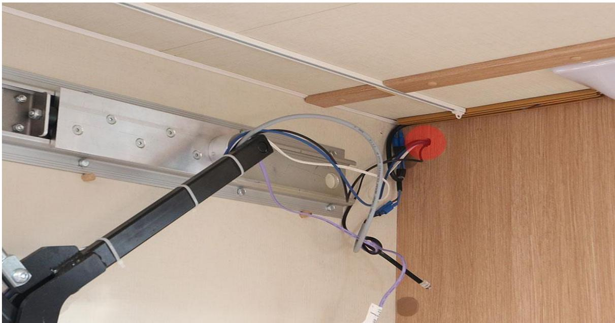
Nun stecken wir das schwarze und rote Kabel durch das Loch und stecken viel Kabel nach. Danach „fische“ ich mit einem Stück gebogenem Draht das Steuerungskabel wieder auf der Seite hervor.
