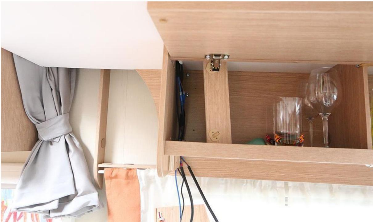
Im abmontierten unteren Deckbrett nun mit einem Borer an der Stelle der zukünftigen Steckdosen je Steckdose in der richtigen Grösse ein Loch bohren.
