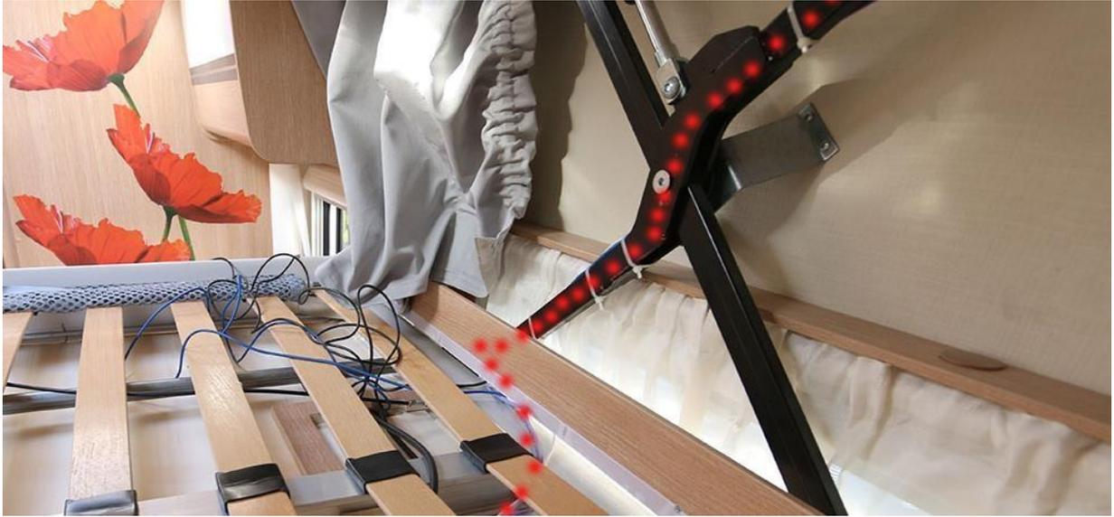
Im Hängeschrack die innere Verkleidung und unten das Deckbrett abmontieren, so dass die Kabel unten raus schauen.
